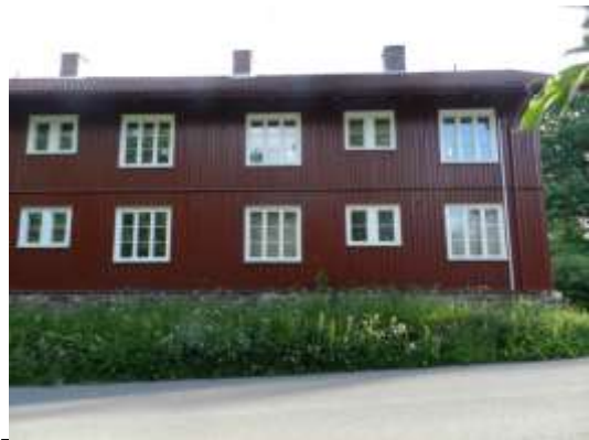
Figur GT1: «Verket» - arbeiderbolig til Grini teglverk er fremdeles bebodd.
