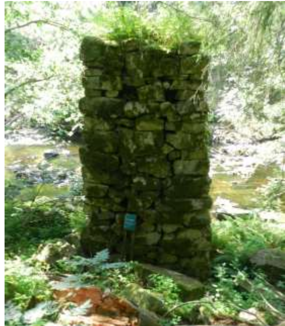
Figur HS1: Den 7 m høye midtre søylen som støttet takbjelkene og sagstolen
