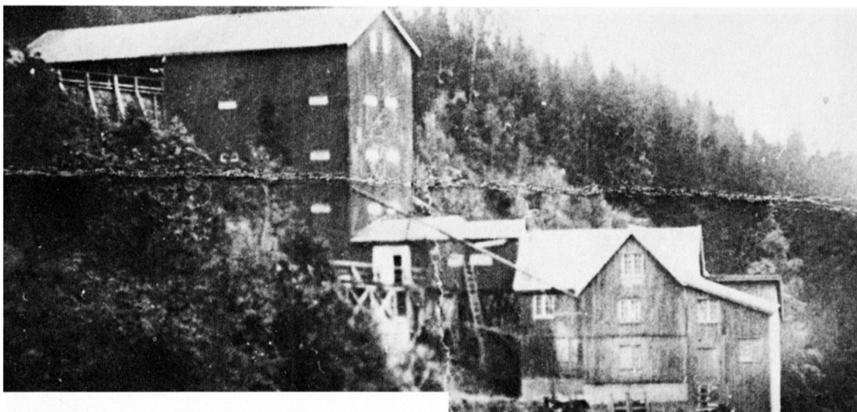
Figur RM8: Fotografi av Rød mølle tatt fra mølledammen. Det viser lagerbygget til venstre og hoved hus på mølla til høyre. I andre versjoner vises demningen nederst og vannrenna som entrer mølla til høyre for den sentrale fløyen i møllas hovedhus. Det bakre bygget med skrånende tak som sees helt til høyre antas å dekke vannhullet
