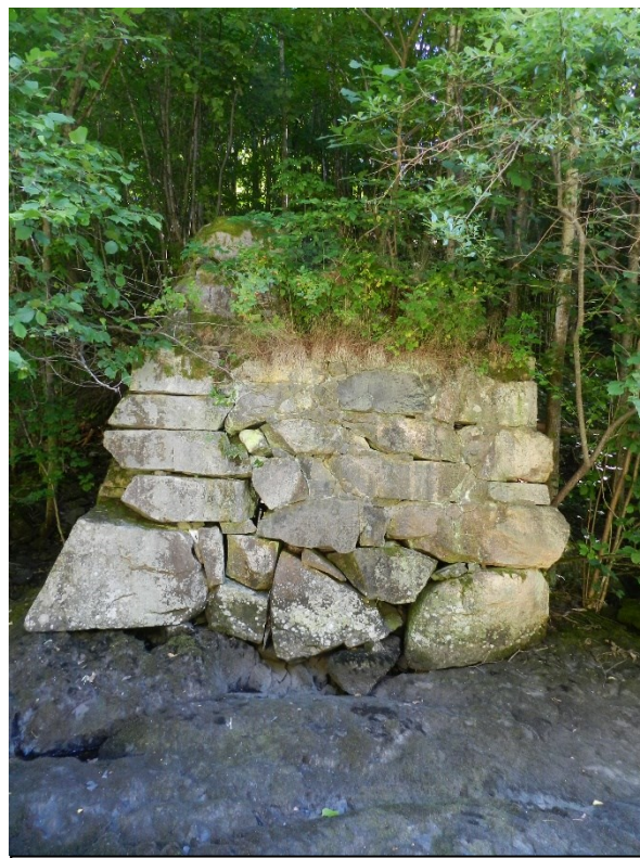
Figur RM14: Damkara sett fra toppen av fossen. Arealet her blir oversvømt ved vannføringer over ca. 2 kbm/sek. Damkara er 3,5 meter høy.
