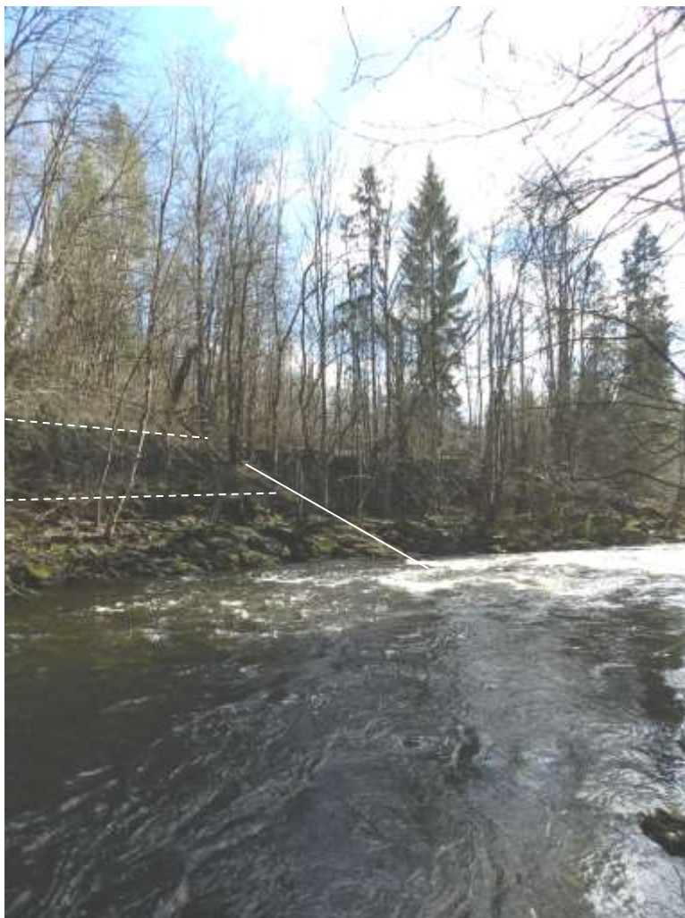
Figur UM7: Mølla sett fra Bærumsiden mot SØ. Merk magmagangen ut i elva (helstrek) som beskyttet bygget mot strømmen og satsene ovenfor mølla (stiplet) som ba vannrenna (nederst) og veien til demningen (øverst).
