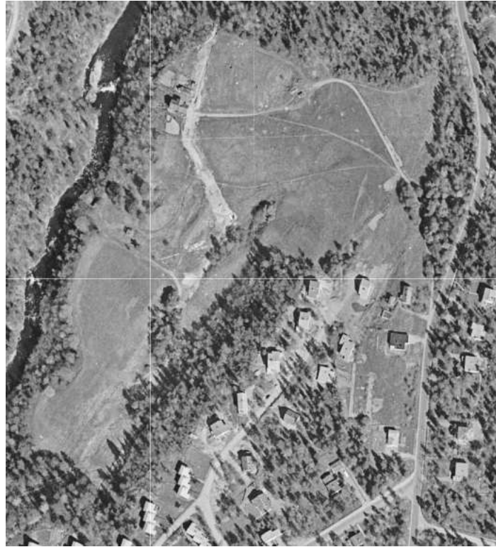
Luftfoto 1956 viser graving for avløpsledning. Stallen og låven på Rolighetsbråten og demningen til Ullern mølle er revet.
