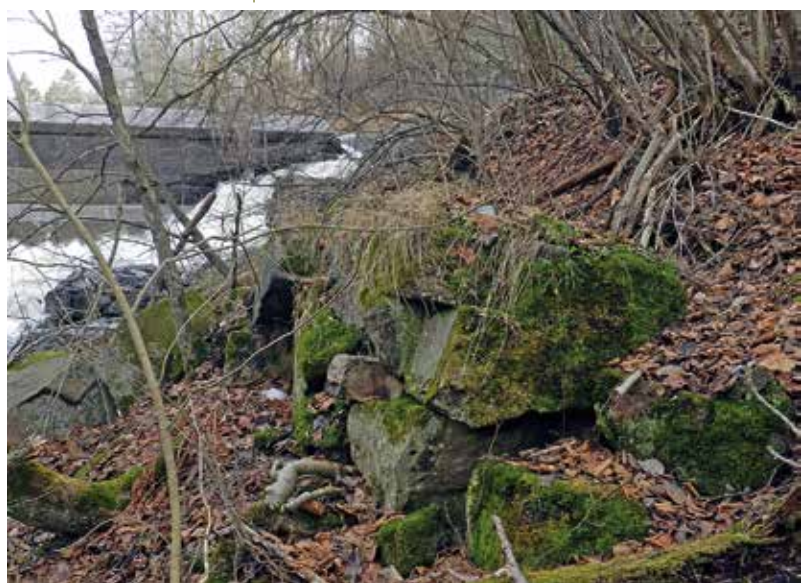
Den største rest etter Rød sag er en lav, 3 meter lang mur. Det er også noen korte støttemurer. I bakgrunnen Grini demning etter ombygging i 2016. Foto John Tibballs 2017
