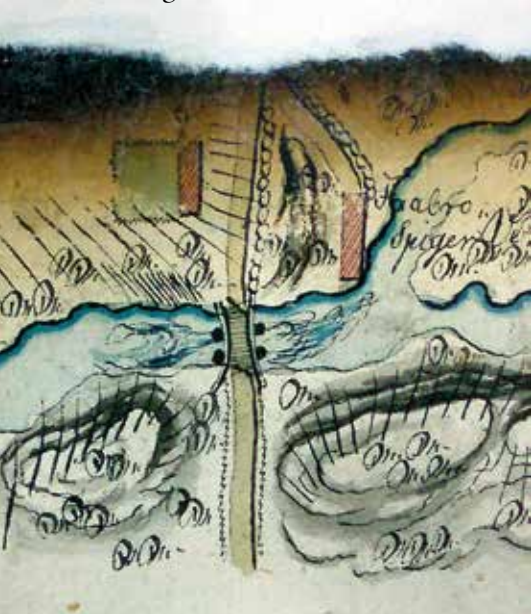
Fåbro spikerverk , med sommerhus til familien Tullin og brua over fossen. Dette er det siste som krigsskolekadetten viser av anlegg nedover Lysakerelva. Merk den brente kanten. Kartet ble funnet i Paleet etter brannen i 1944. Utsnitt fra en krigsskolekadetts Croqui over Elven fra Bogstad til Lysager . [Nasjonalbiblioteket Kart 3555. no-nb_krt_00391, ca. 1808]
