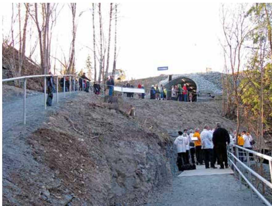
Da Kolsåsbanen ble modernisert, realiserte Oslo og Bærum kommuner turveiforkjempernes ønske om en passasje gjennom Jarfyllingen. I løpet av tre sommeruker i 2009 ble en kulvert satt på plass og 10. mai 2010 kunne ordførerne i fellesskap åpne Fådpassasjen . Foto Bo Wingård 2009-10
