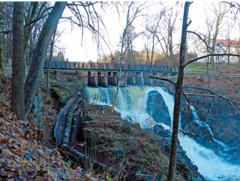
Fåbrofossen . Legg merke til vannrørene til turbinene mot Mustad (t.h.) og mot Granfos (t.v.). Meget lav vannføring, 400 liter per sekund. Foto John Tibbals 2018
