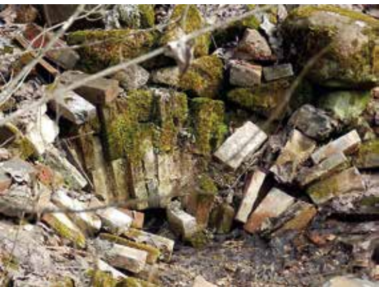
Masovnen på Fossum. Ovnen er gjenfylt med jord og murstein, for å holde konstruksjonen oppe, men den er ellers ubeskyttet. Teglstein forsvinner år etter år. Foto John Tibballs 2013
