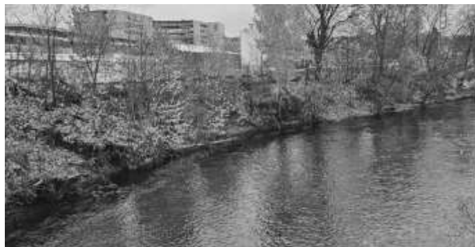
Strekning hvor Fornebubanen vil plastre elvekannten for å stoppe erosjon.
